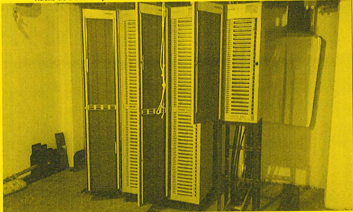
Racks de Dimmers, controlan toda la iluminación Escénica e iluminación de sala
